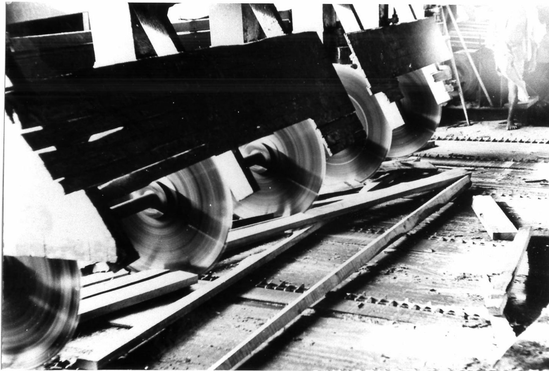
Tronçonnage des déchets avec les scies circulaires fixes « slasher » et évacuation au broyeur pour l'alimentation de la chaufferie
