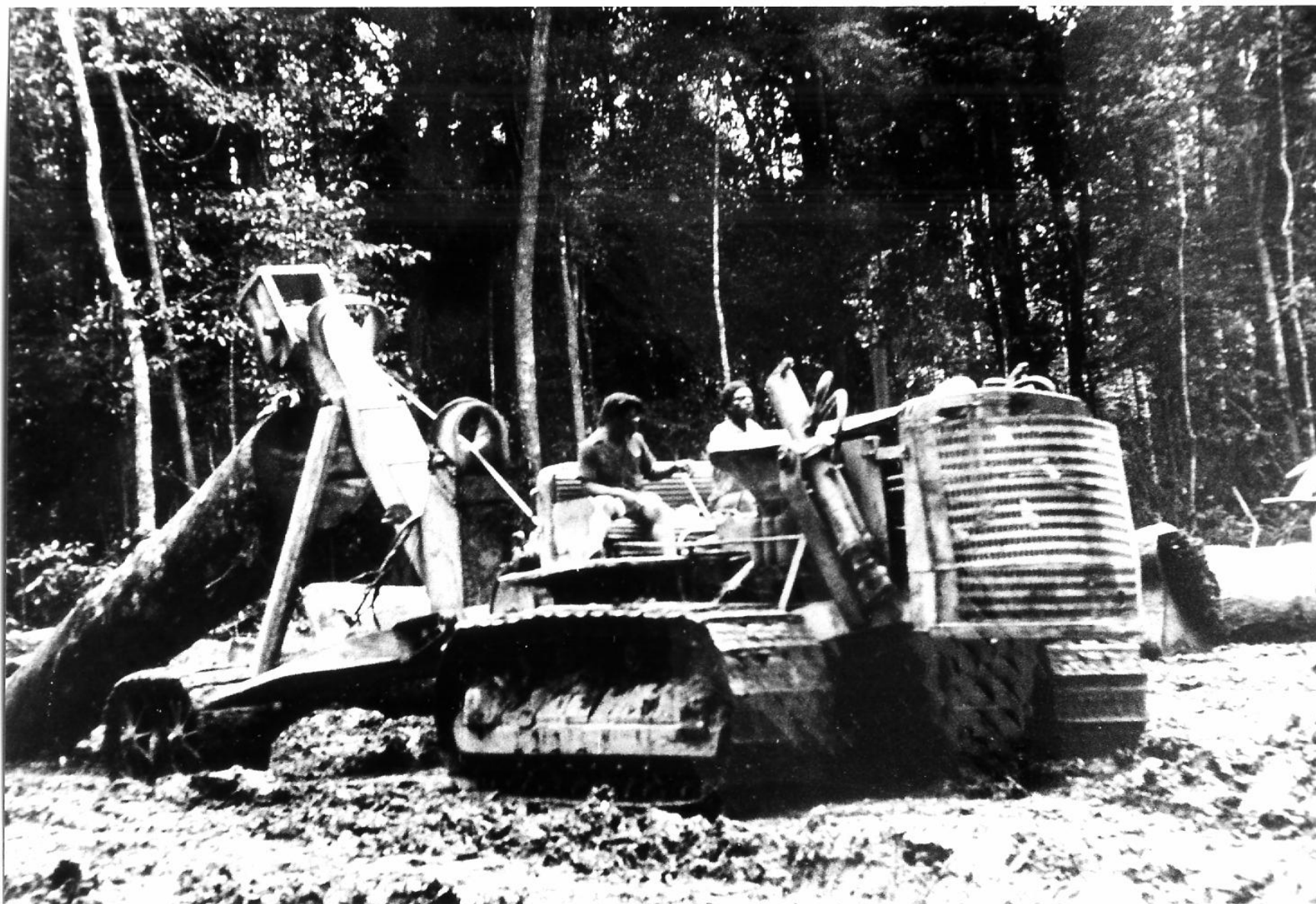
Vue de face du débardage avec tracteur à chenilles type Caterpillar Equipé d'une arche à chenilles
