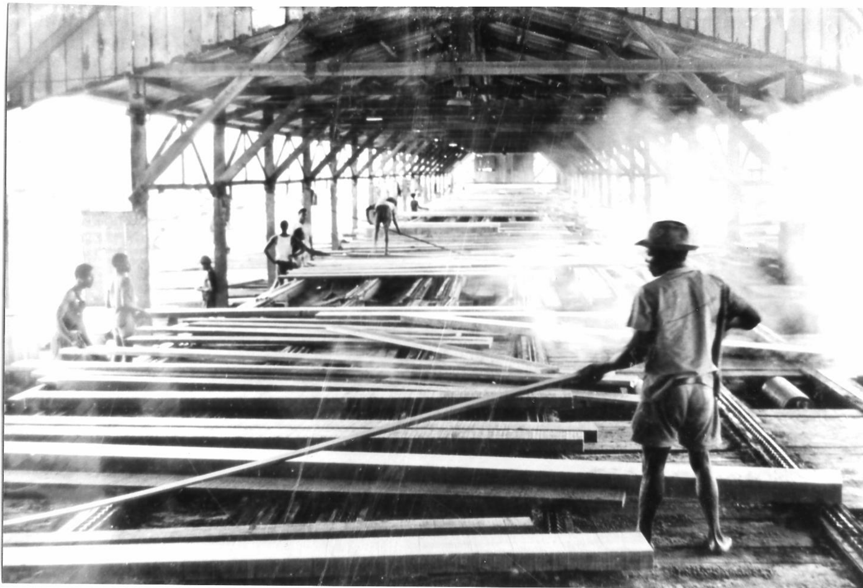
Chaîne de triage des débits avec empilage sur les côtés des avivés et au bout des traverses de chemin de fer
