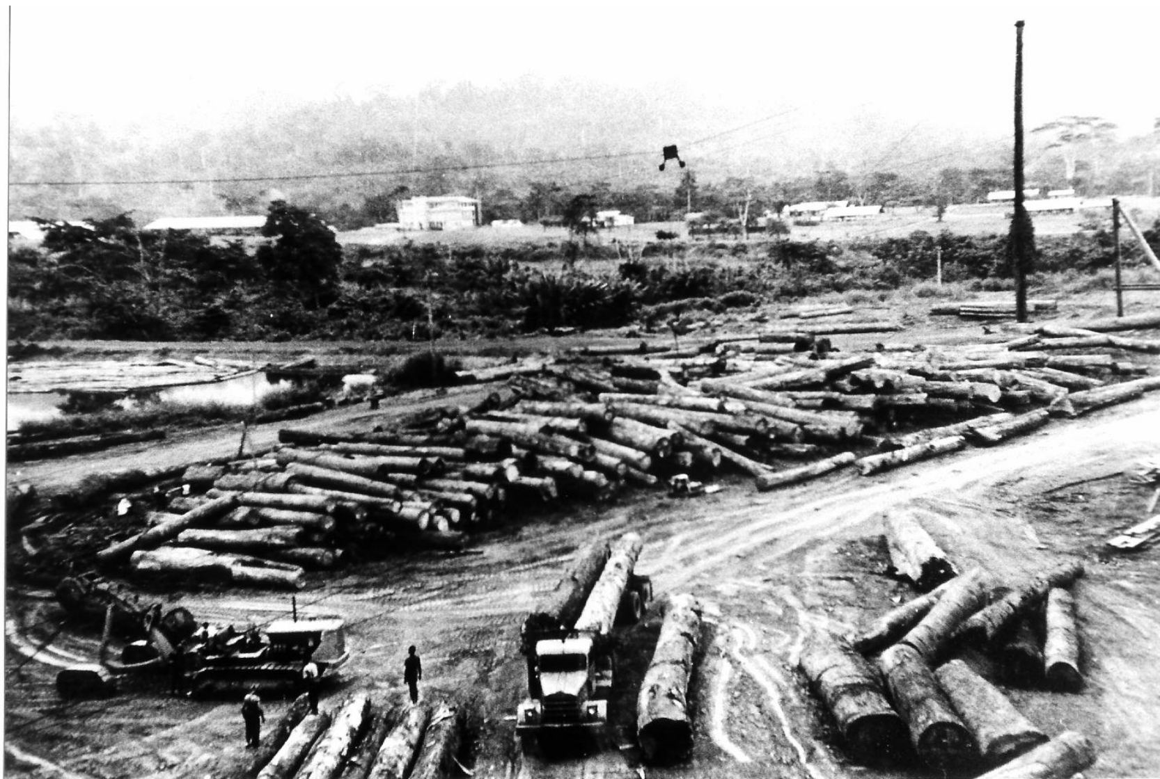
Vue d'ensemble du parc à grumes (parc à eau et parc à terre) où sont stockés les bois exotiques. Les bois fragiles, pour éviter piquûres, gerces, Fentes de séchage, sont mis à l'eau
