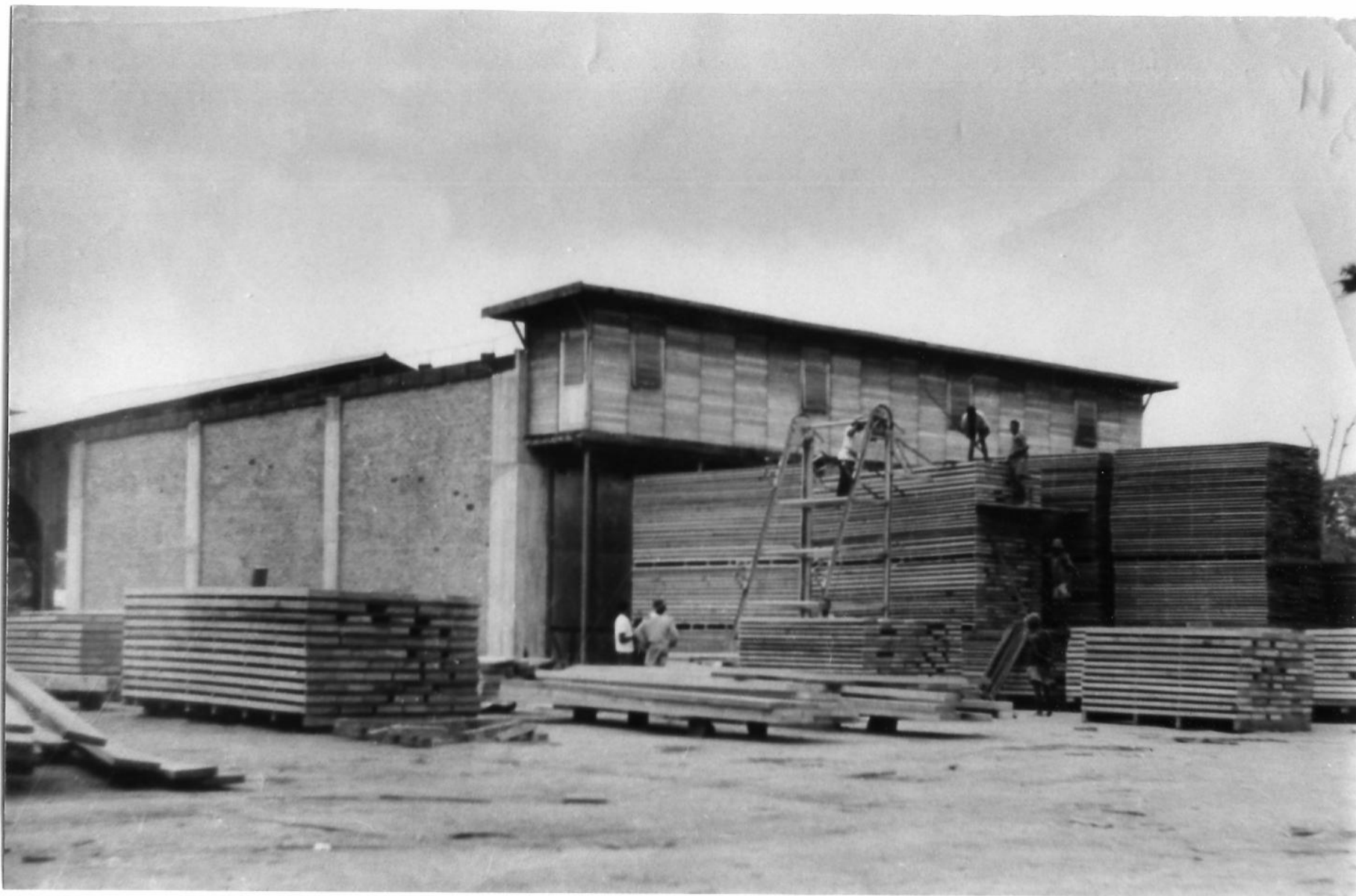
Séchoirs à bois de type BOLLMAN A noter le système d'élévation des produits pour l'empilage
