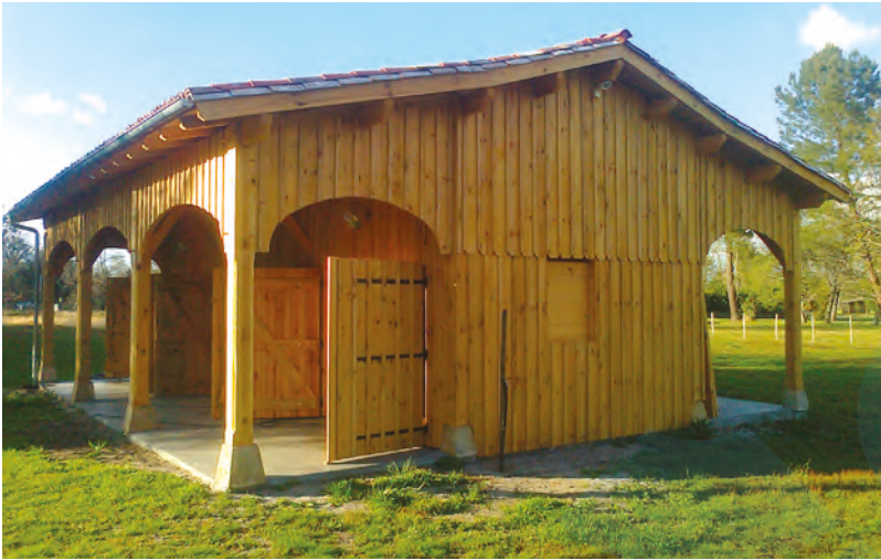
Grange des landes gironnaises réalisée entièrement en bois de construction de la scierie Labrousse.
